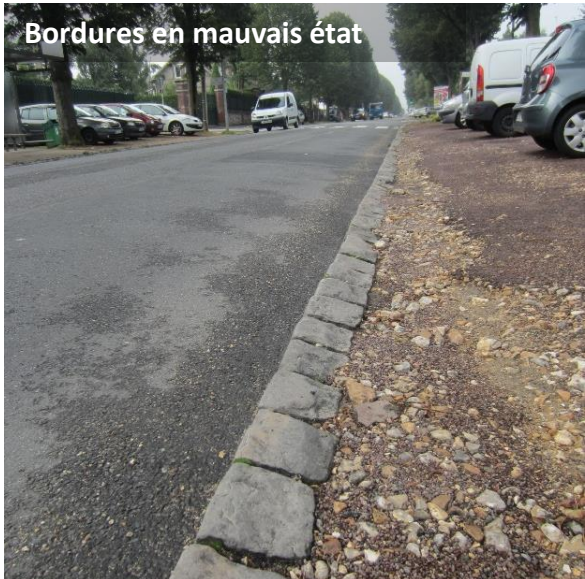
Chaussée dégradée et marquage effacé
