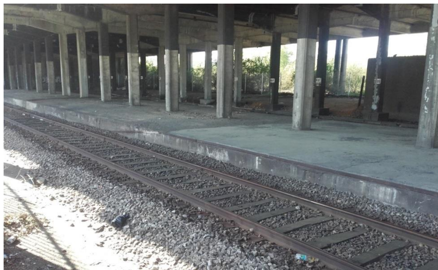
Photo 7 : Détail de la tranchée couverte ferroviaire (ouvrages de type M)
