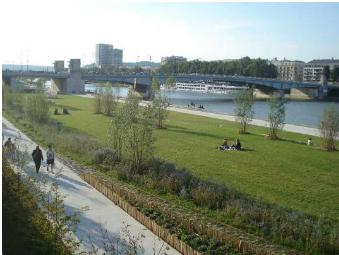
Photo 2 : Vue d'ensemble sur la prairie Saint-Sever entre les ponts Corneille et Boieldieu.
