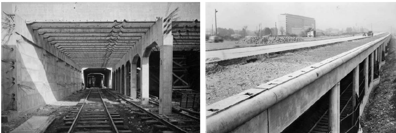
Photo 6 : vues du chantier de construction de la tranchée couverte (1951)
