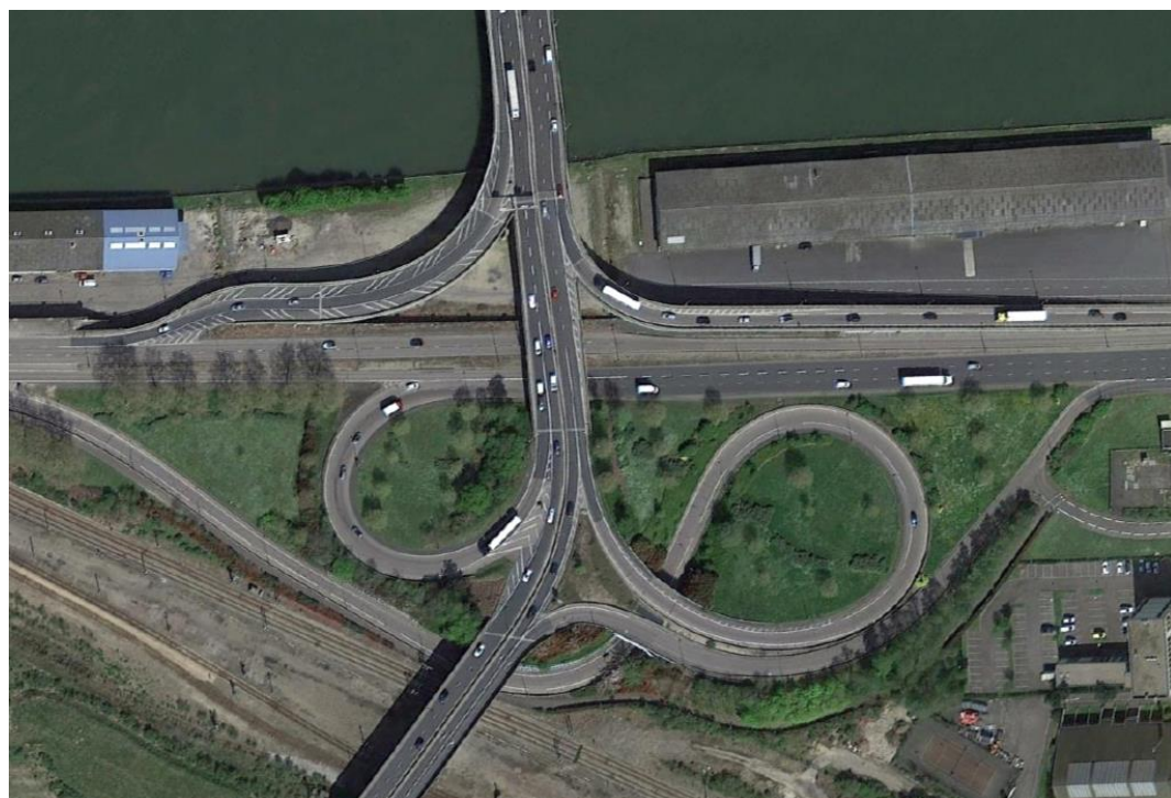
Illustration 51 : Vue aérienne de l'échangeur sud du pont Mathilde
