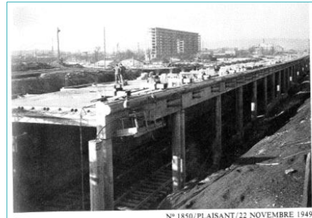
Photo 5 : Vue sur le chantier de construction en 1949
