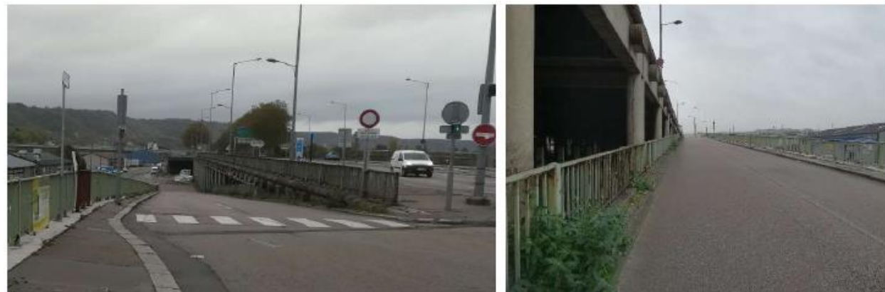
Photo 3 : Vues sur l'actuelle rampe d'accès aux quais bas
