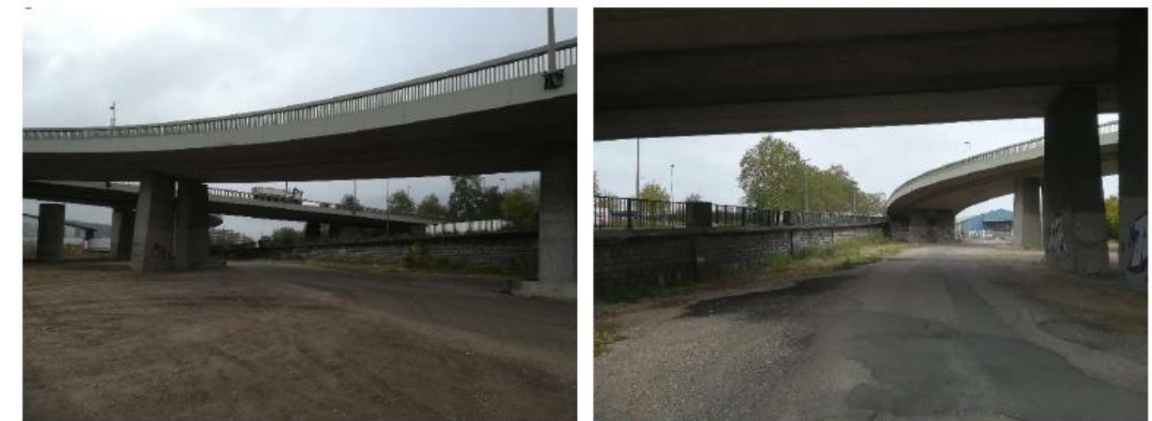
Photo 4 : Vues sous les bretelles actuelles et l'extrémité de la tête sud du pont Mathilde
