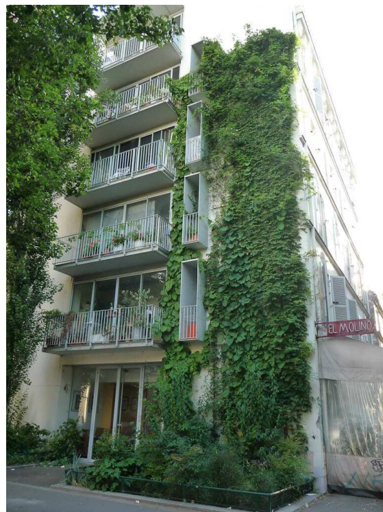
Mur végétal version plantes grimpantes dans l'avenue Jean Jaurès (Paris 19e) 12
