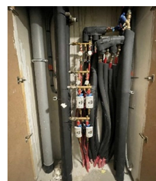
Organe de production de l'ECS avec respect des minimum 50 degrés réglementaires
