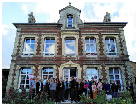
Le Presbytère - 2021 Quillebeuf-sur-Seine 5 logements Locatif Social Néologis / SNL
