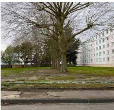
Canadiens : immeubles à démolir
