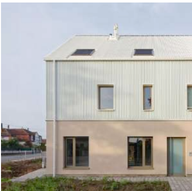
Absence de boîte à eau ballast, Rixheim
