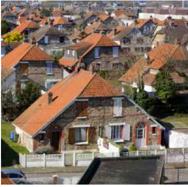
Toiture en tuile mécanique en terre cuite rouge - Cité-jardin, contexte existant
