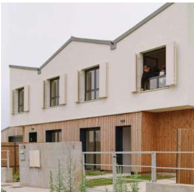
Absence de boîte à eau + volets LA architecture, Courneuve
