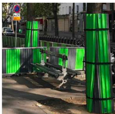
Gestion de chantier
