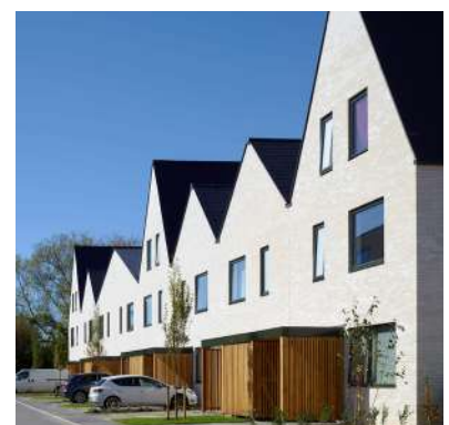
Toiture ardoise - Allford Hall Monaghan Morris, Oxford
