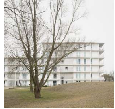
Logement collectif ATAMA, Eeklo
