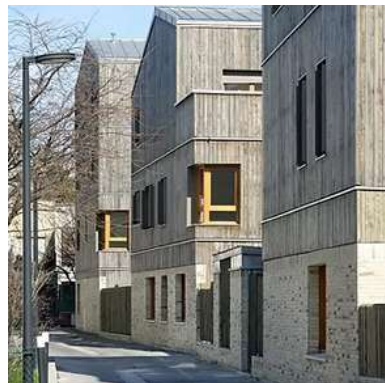
Bardage bois et menuiseries bois Atelier Desmichelle, Saint-Denis
