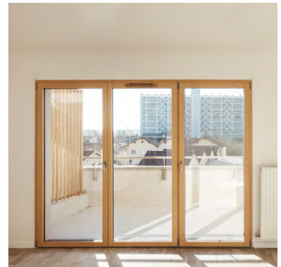
Châssis bois - LA Architecture, La Courneuve
