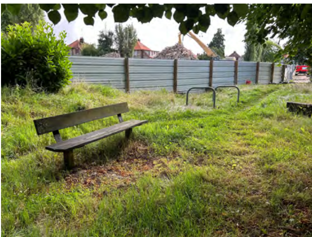
Figure 5 - Mobiliers et autres ouvrages démolis par Rouen Habitat
