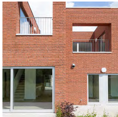
Travail volumétrique en briques Reservoir A, La Docherie
