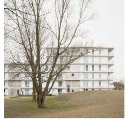
Logement collectif ATAMA, Eeklo
