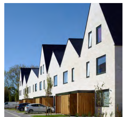
Toiture ardoise - Allford Hall Monaghan Morris, Oxford
