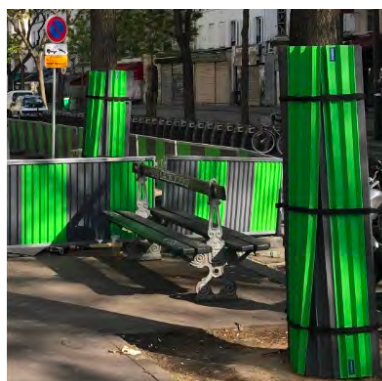
Gestion de chantier
