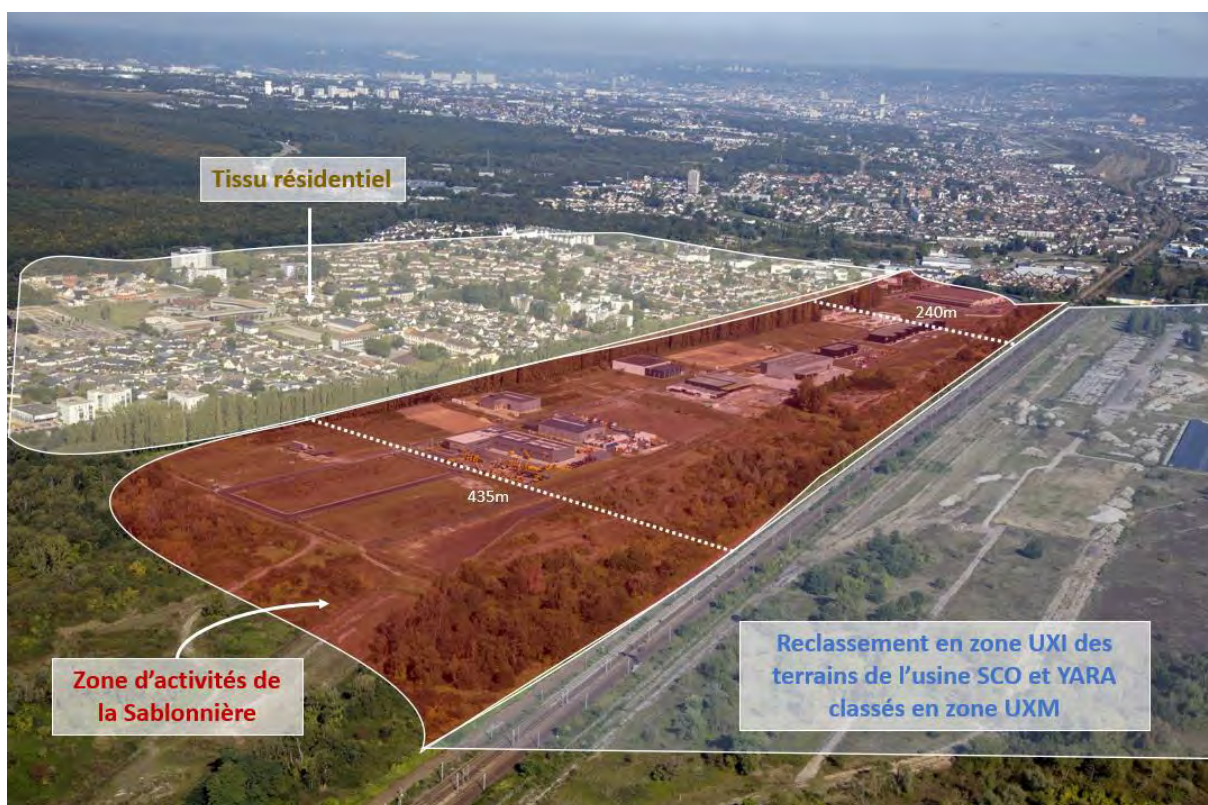
Figure 9 : Vue de drone sur la zone d'activité de la Sablonnière
