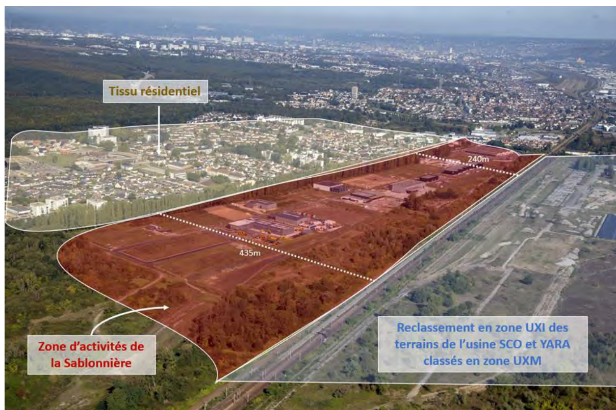
Figure 23 : Vue de drone sur la zone d'activité de la Sablonnière
