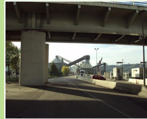
Accès au terminal sucrier
