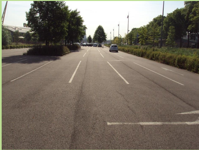
Boulevard de Béthencourt
