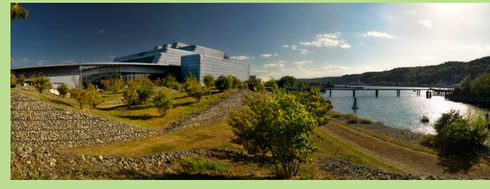
Bloc photo 24 - Installations de l'UVE VESTA (SMEDAR)
