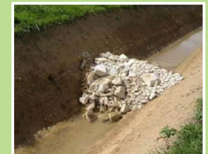
Seuil en pierre permettant de ralentir les écoulements
