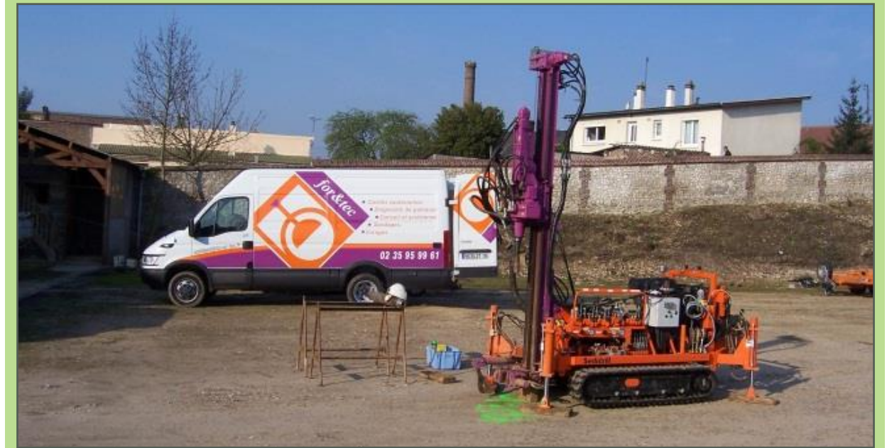
Bloc photo 27 - Exemple de matériel pour la réalisation d'investigations géotechniques
