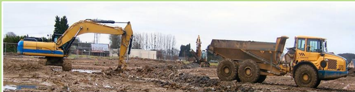
Engins de chantier et travaux mécaniques
