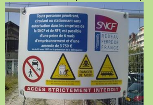
Bloc photo 32 - Exemple de signalisation de sécurité en phase chantier : Accès interdit à la zone ferroviaire et présentation des risques
