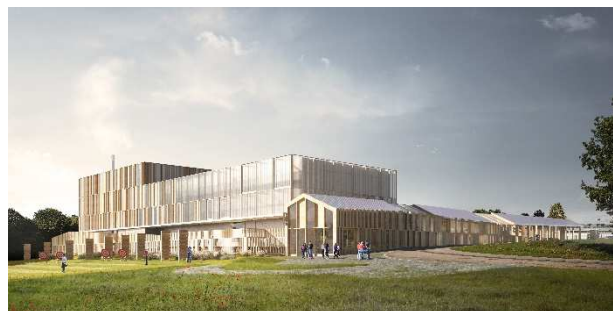
Projet d'extension de la chaufferie de la Petite Bouverie
