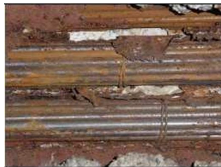
Câbles de précontrainte apparents
