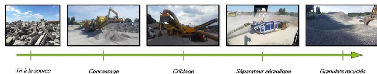
Illustration 19 : Chaîne de traitement des produits de démantèlement de la tranchée couverte
