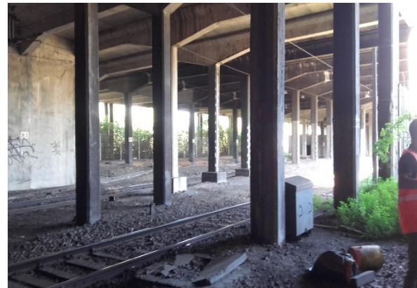
Schéma et photo (visite des lieux) d'un portique « large » de type M
