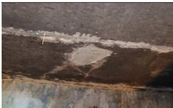
Dépôts de calcite et concrétions calcaires
