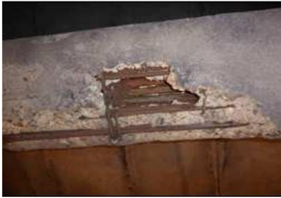
Eclats de béton et fers apparents sur la majorité des éléments de l'ouvrage
