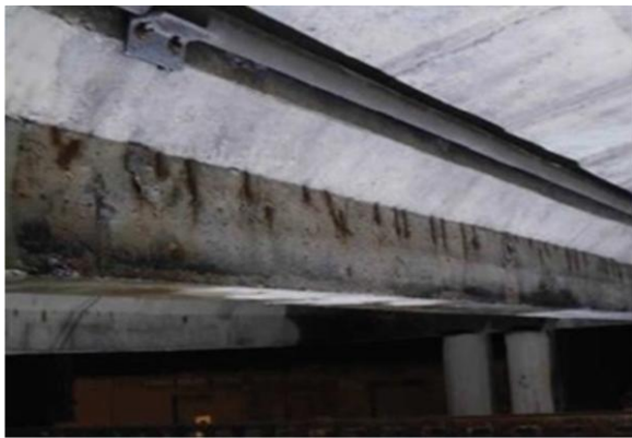
Zone de béton altérée
