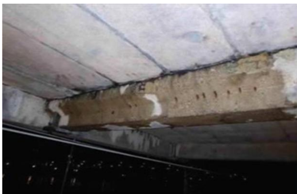
Zones humides sur les voiles et sur le hourdis
