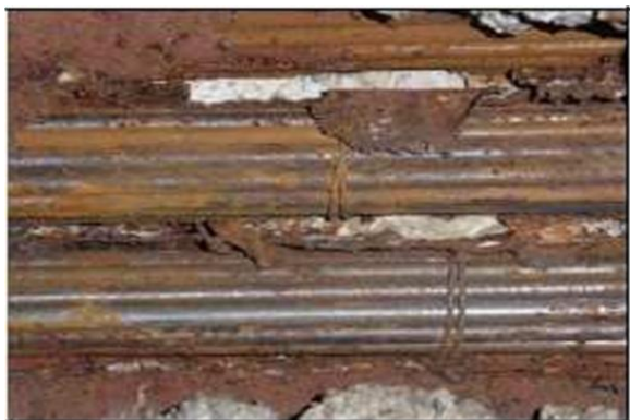
Câbles de précontrainte apparents
