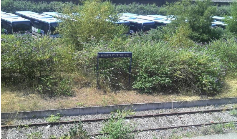
Panneau de quai indiquant l'emplacement de l'ancienne gare SAINT SEVER en 2020
