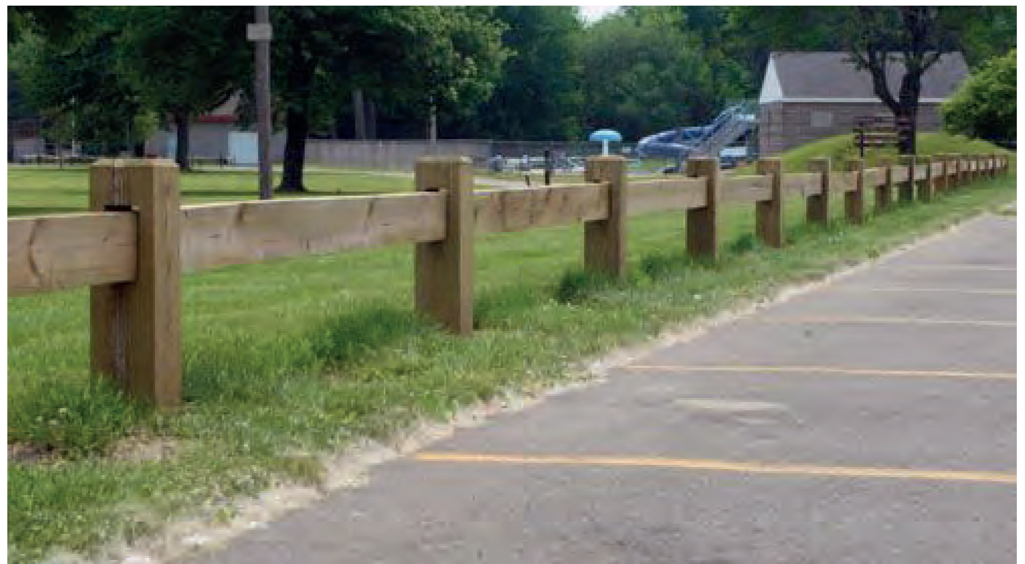
Type de lisses de sécurité basse installées en bord de voie - bois classe 4
