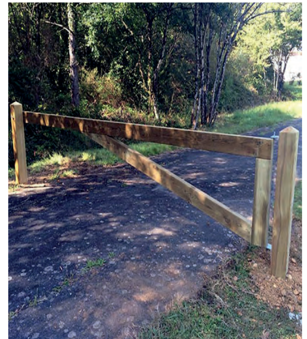
Barrière pivotante pour fermer certains accès à la voie
