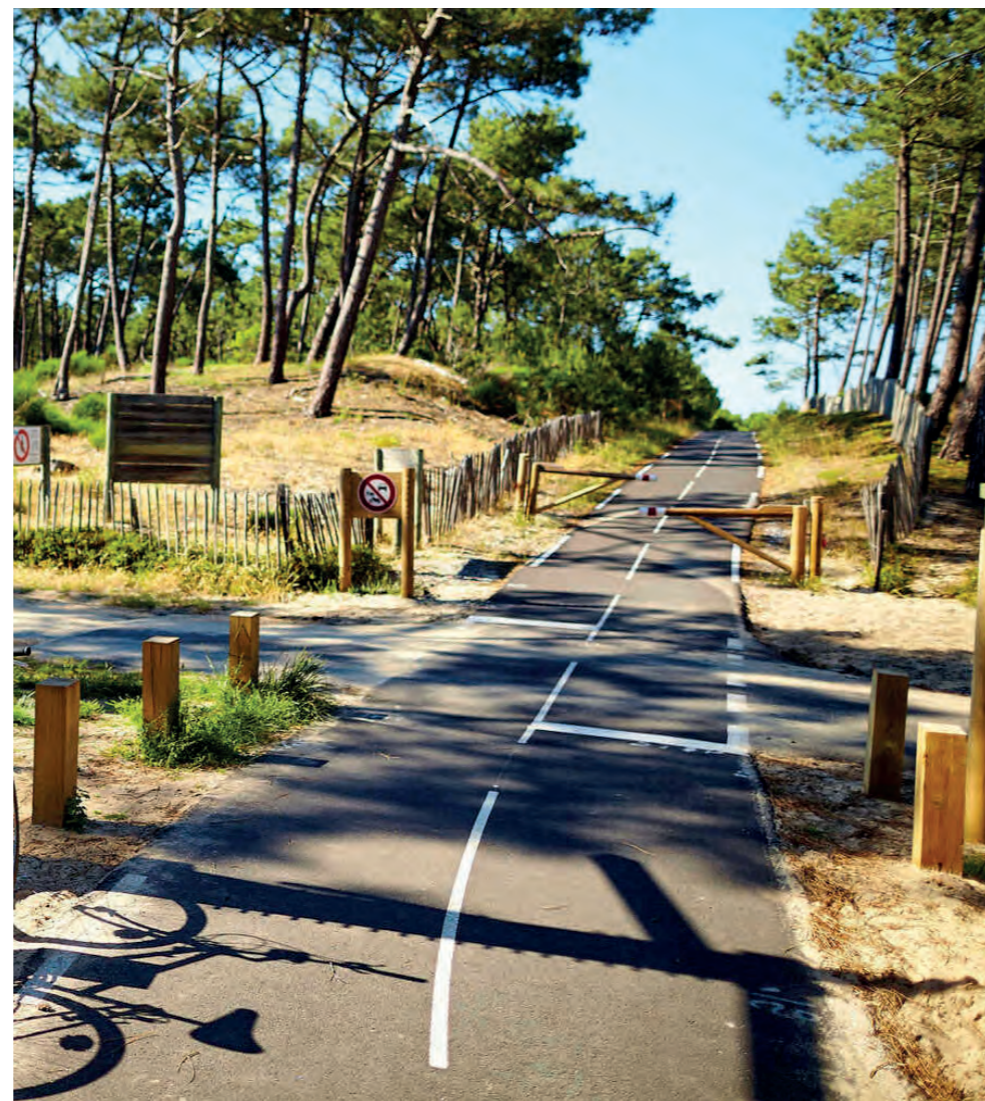
Barrières pivotantes - implantées le long de la voie
