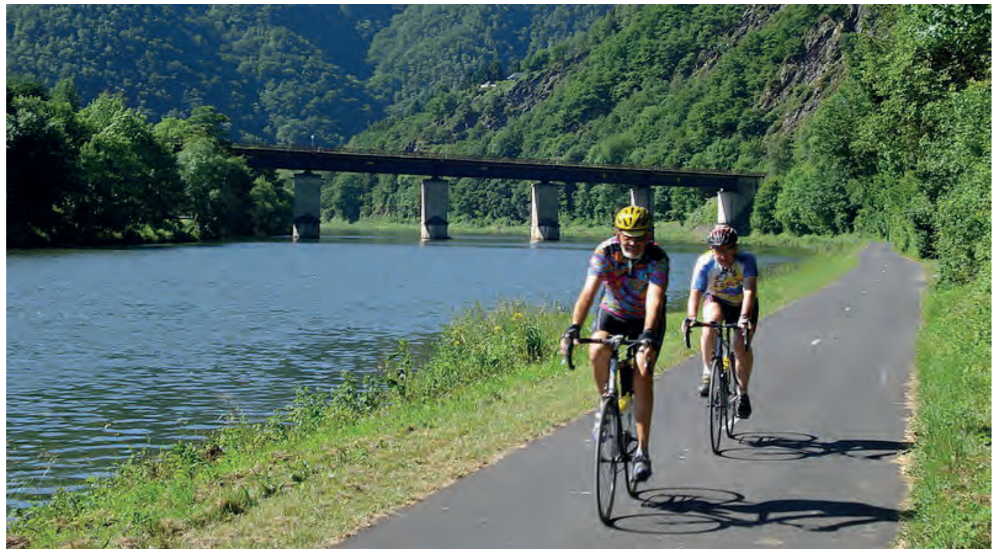
Voie verte en enrobée - Trans-Ardennes
