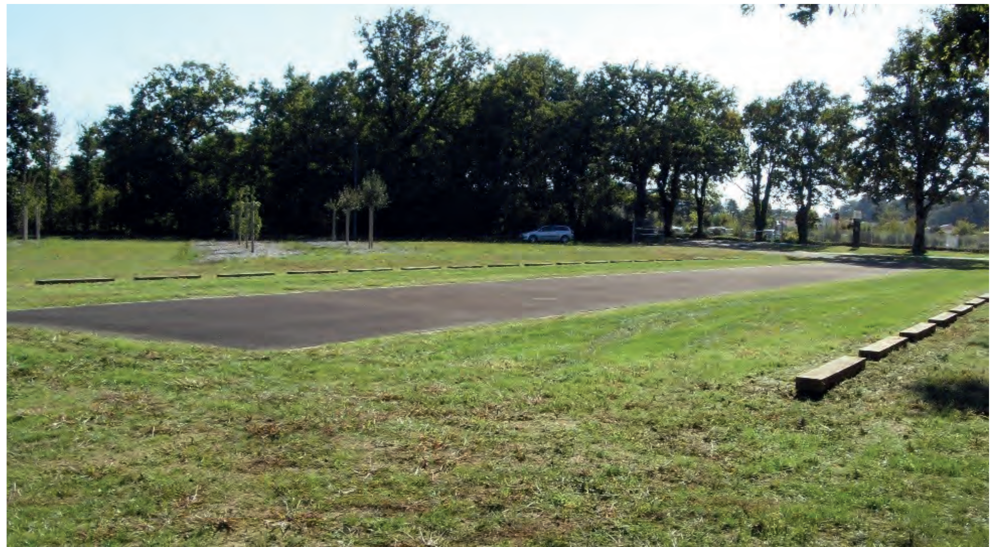
Exemple de stationnement en revêtement terre-pierre - La Roche-sur-Yon (85)
