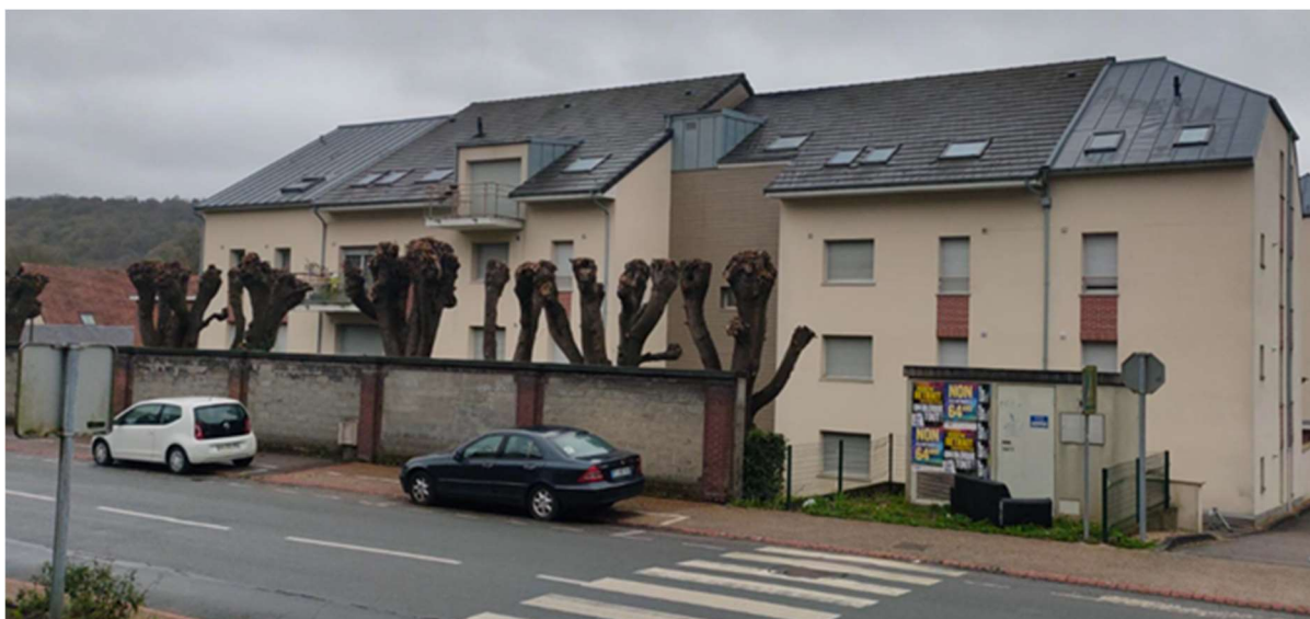
Résidence récente le long de la route de Dieppe : volets fermés à cause du bruit
