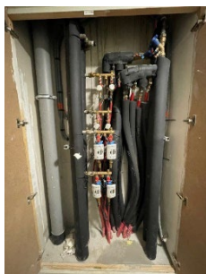
Colonne d'équilibrage chauffage et ECS du palier d'un étage
