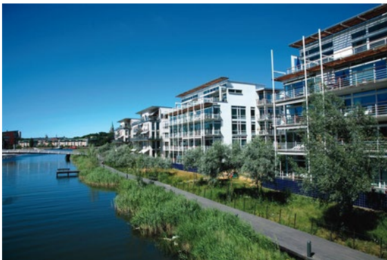
Une ancienne friche sur l'autre rive, un canal, des îlots apaisés, etc...
