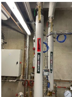
Colonne d'équilibrage chauffage et ECS du palier d'un étage
