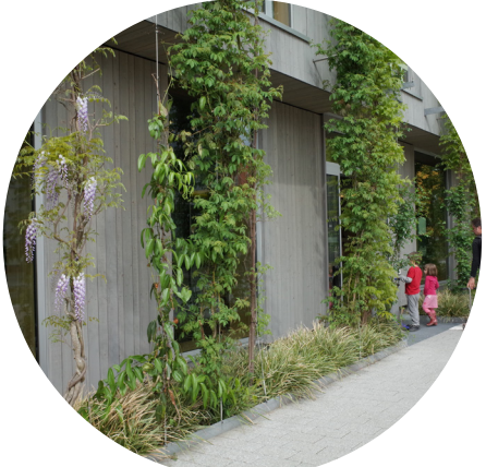
Seuil des logements Mise à distance plantée et plantation de grimpantes en façade
