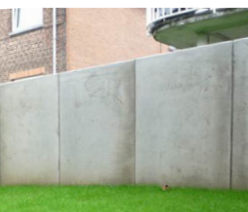
Mur de soutènement béton préfabriqué - semelle béton
