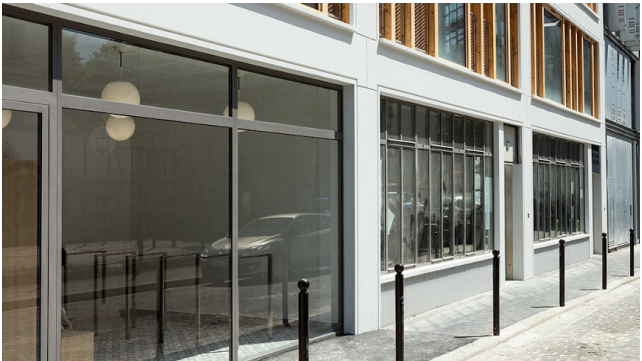
6.6 Locaux vélos ouverts en RDC Rue Charrière, Paris 11e. Mobile architectural Office
